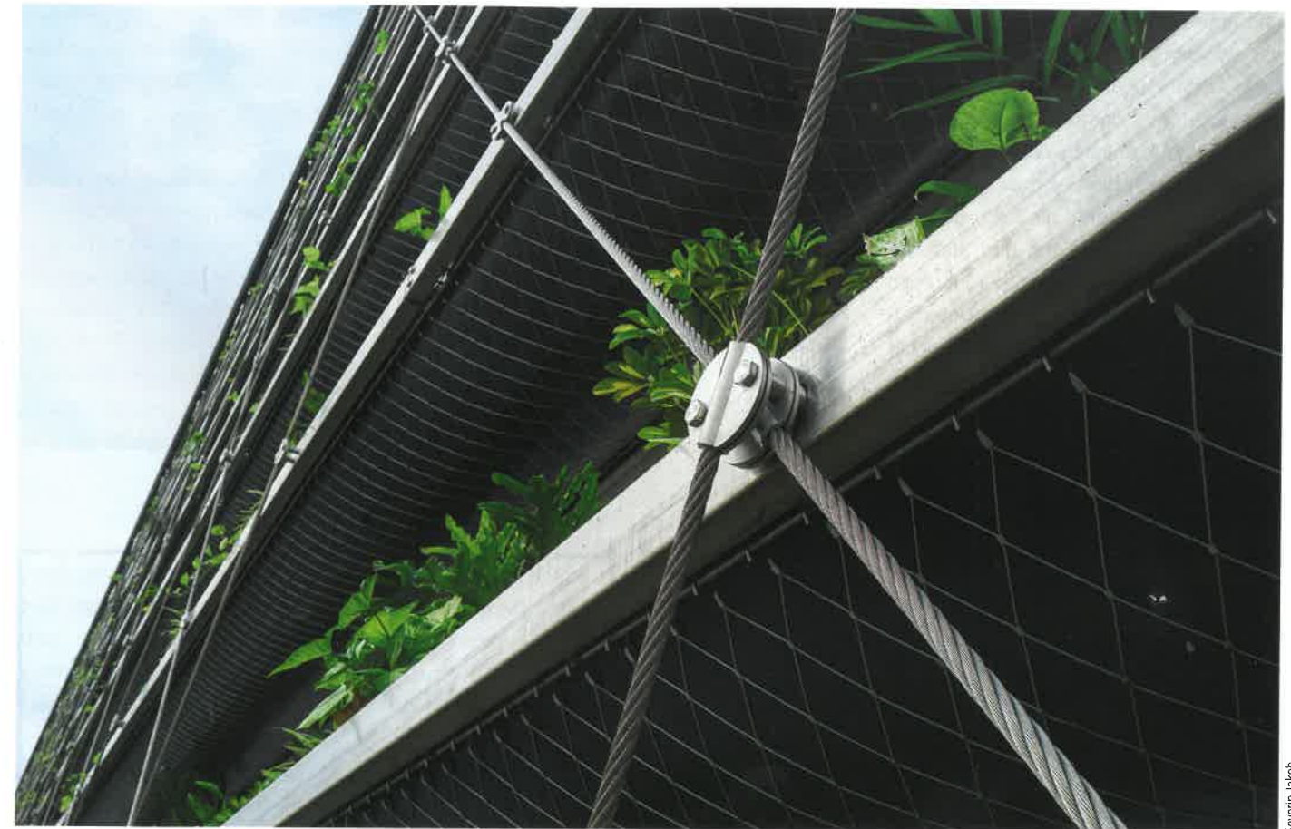
Getragen wird die Konstruktion von einer zwischen Boden und Dachrand gespannten zweilagigen Seilkonstruktion. Bild: Severin Jakob
