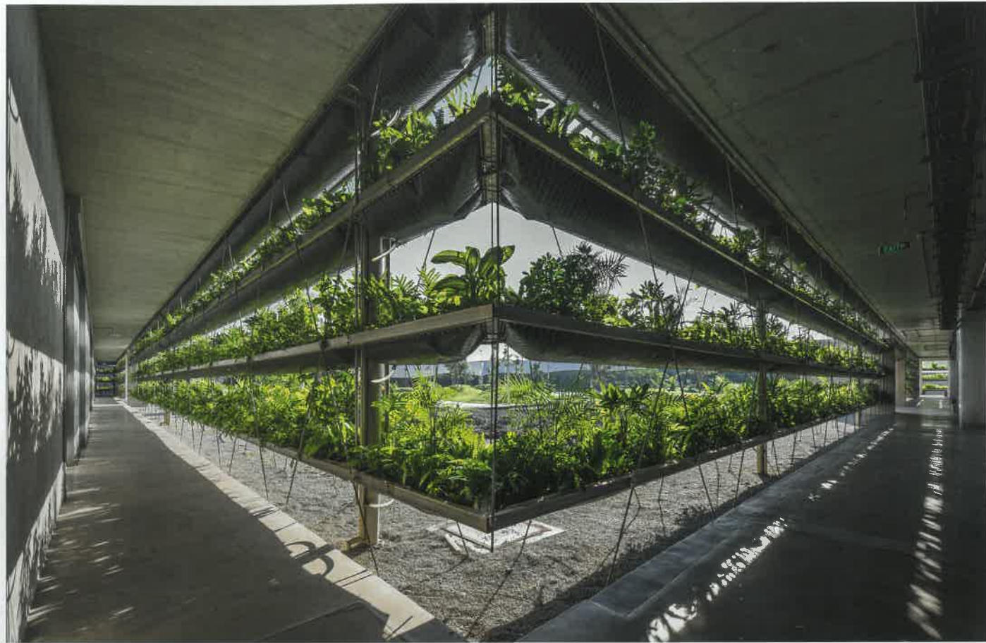
Horizontal übereinanderliegende Lamellen erfüllen die Aufgabe der Beschattung und des Regenschutzes.
